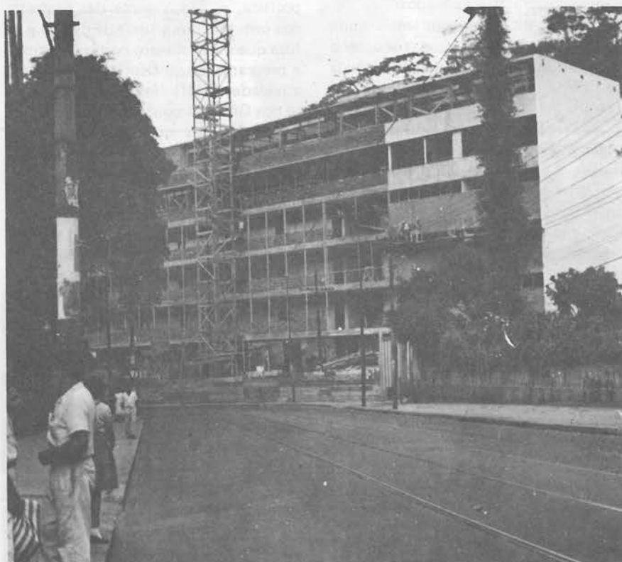
Construção do prédio
