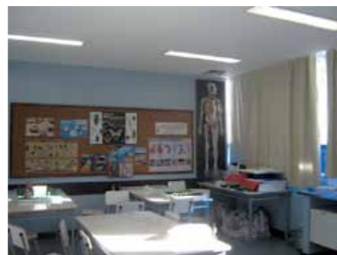
ALGUMAS OBRAS DAS FÉRIAS: DE CIMA PARA BAIXO, A FACHADA, O TELHADO E O INTERIOR DO GINÁSIO, A NOVA SALA DE EXPOSIÇÕES, A SAÍDA DOS ALUNOS REFORMADA E O LABORATÓRIO DE BIOLOGIA COM NOVAS PAREDES DE DRYWALL
